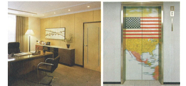
ダイノックシート仕上げ 窓ガラスの飛散防止フィルム貼り
