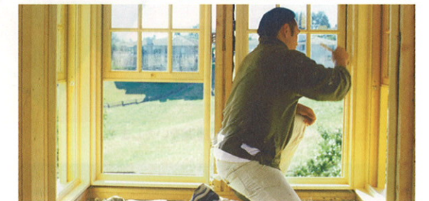
ダイノックシート仕上げ 窓ガラスの飛散防止フィルム貼り
